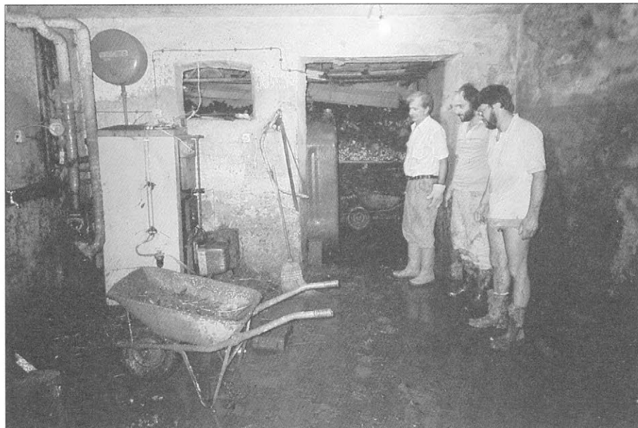
Slika 8. Neurje na območju Trbovelj 28. 6. 1994, višina vode (levo od okna nad pečjo) v kleti na spodnji strani Ceste oktobrske revolucije Figure 8. Vicinity of Trbovlje, June 28, 1994, high water levels (left of window, above furnace) in a cellar on October Revolution Street
