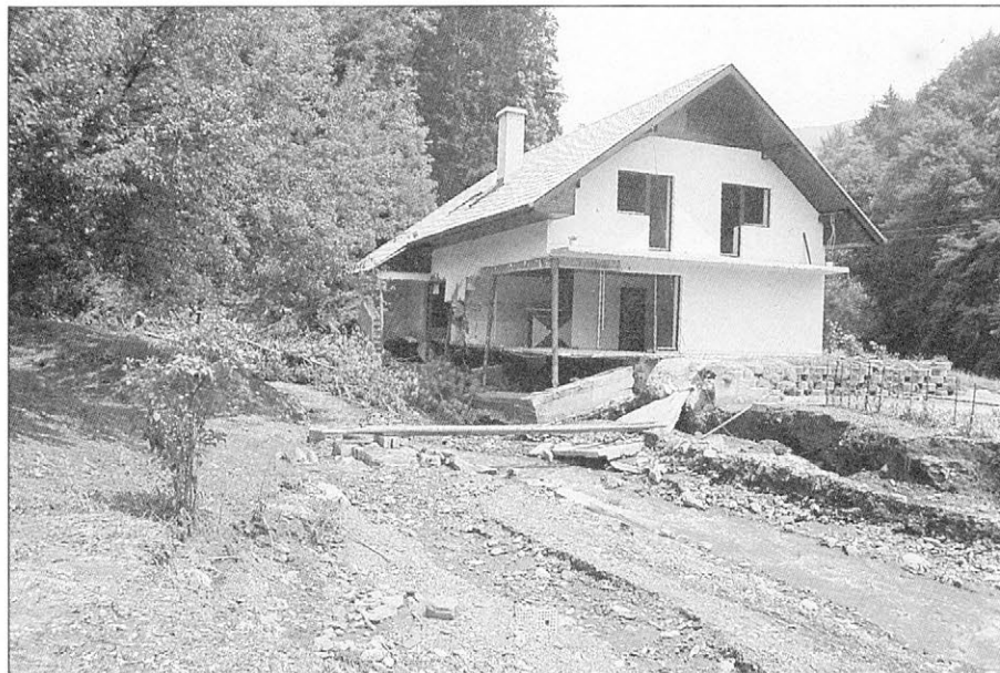
Slika 4. Neurje na območju Trbovelj 28. 6. 1994, hudourniški pritok Prešnik je povsem spodjedel temelje pred kratkim zgrajene stanovanjske hiše, zgradili so jo na neprimerni lokaciji neposredno ob strugi, v povirnih delih Kotredešnice bomo ob potoku le stežka našli stare hiše, ki bi bile postavljene tako nespametno
