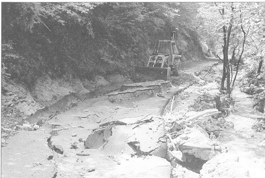
Slika 3. Neurje na območju Trbovelj 28. 6. 1994, cesto Potoška vas–Partizanski Vrh so asfaltirali le nekaj tednov pred neurjem; v ozki grapi pod Pečnikom so se Konjščica in njeni stranski hudourniški pritoki zajedli v cestno telo in ga povsem uničili, s kakšno silo je drla voda, vidimo po velikosti kamninskega gradiva, odloženega ob robu ceste
