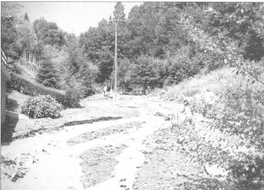
Slika 4. Na mestih, kjer prehaja vodotok s strmejšega gornjega toka v bolj položno dolinsko dno, se odložijo presežki plavin – prod in peska; transportna zmogljivost vodotoka se hipno zmanjša; neustrezni objekti, kot so prenizko dimenzionirane premostitve ali neprimerne ureditve, še dodatno poslabšujejo razmere; na sliki je desni pritok Trboveljščice na prehodu s površnega v bolj položen odsek
