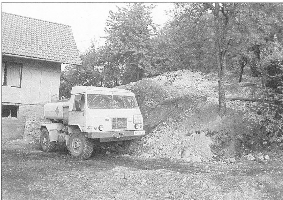
Slika 4. Hiša na zgornjem robu naselja (Golnik št. 27), kamor je skrenil desni krak hudourniškega Hudega grabna: za tovornjakom so na hiši vidni sledovi gruča, ki označujejo višino kamninskega nanosa; pritisk kamninske mase je grozil, da bo porušil zgornje zunanje stene stanovanjske hiše
