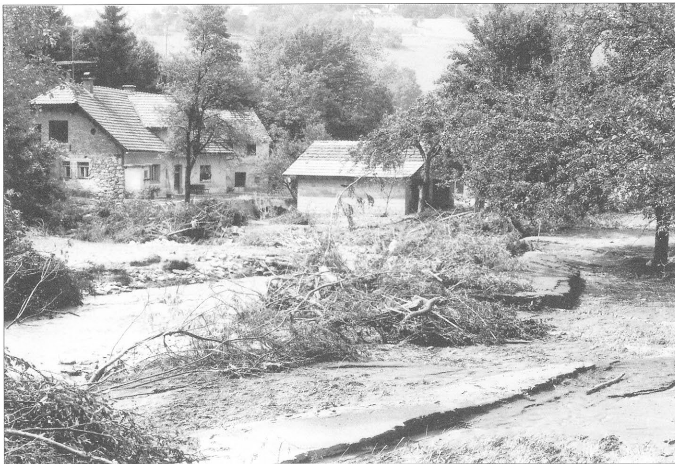
Slika 1. Številni domovi ob Konjščici so bili preplavljeni, na njihovih seliščih je povodenj zapustila pravo razdejanje Figure 1. Flooded homes along the Konjščica stream
