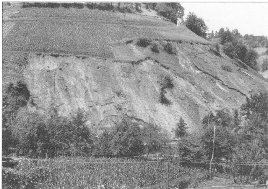
Slika 13. Spodnja pobočja Križnikovega hriba (Ojstrica pod Črnim Vrhom) so razorali in ogolili številni zemeljski plazovi in usadi
