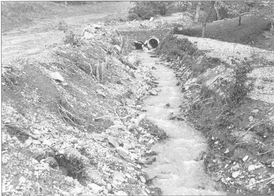
Slika 9. Usad in novonastali vršaj sta zatrpala strugo enega izmed povirnih krakov Konjščice pod Štrbenkom (869 m); očiščena struga in obnovljeno cestišče sta odprla pot domačinom v svet Figure 9. Landslips and debris clogged the bed of one of the Konjščica stream's minor tributaries at Štrbenko (869 metres)
