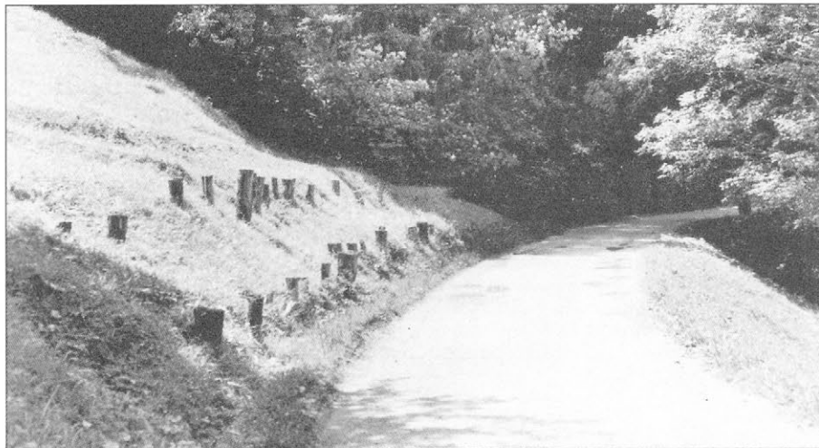
Slika 15. Cesta med Šentgotardom (pri Trojanah) in Zaplanino je zavarovana s "piloti"; tako so ustavili premikanje pobočnega materiala in nastanek zemeljskega plazu ali usada
