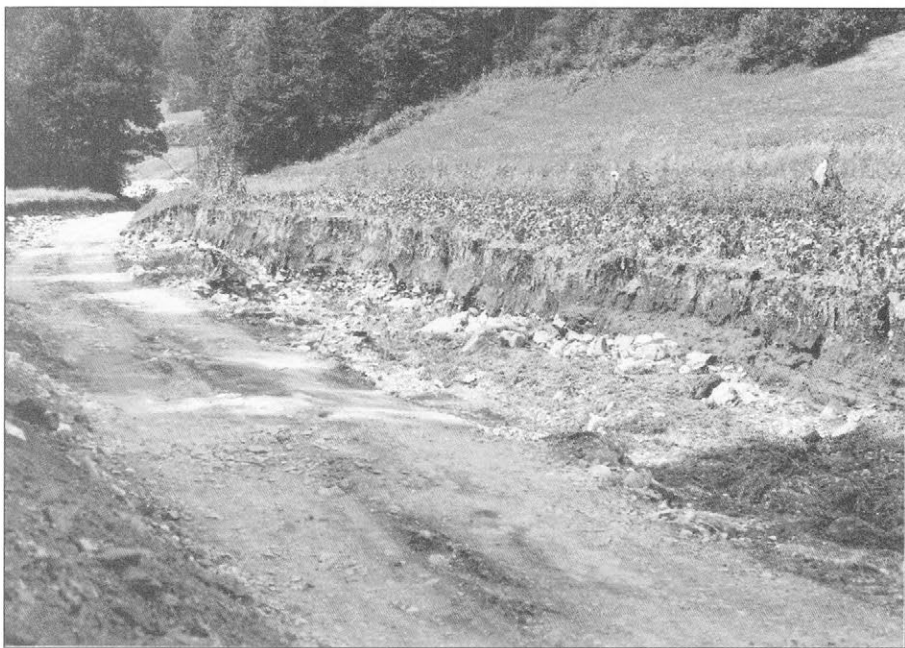
Slika 5. Cesto v Zaplanino je neurje popolnoma uničilo; pri Kovaču si je izkopala Zaplaninščica na utrjeni asfaltirani cesti novo strugo, staro pa zasula s kamenjem; odplavila je del Kovačeve njive v dolžini 100 m in širini 3 do 6 m
