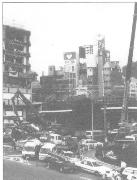
Slika 15. Za podiranje delno porušene stavbe uporabljajo težko mehanizacijo Figure 15. Heavy machinery is used to demolish a partially collapsed building
