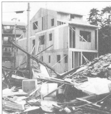
Slika 14. Ob ruševinah je že zgrajena nova, potresno odporna hiša Figure 14. A new, earthquake-resistant house already stands not far from ruins
