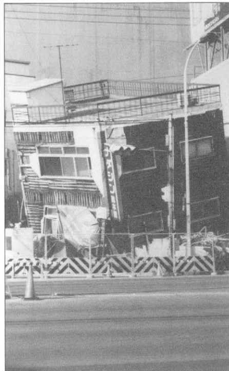
Slika 6. Nagnjena lesena hiša zaradi porušitve pritličja
