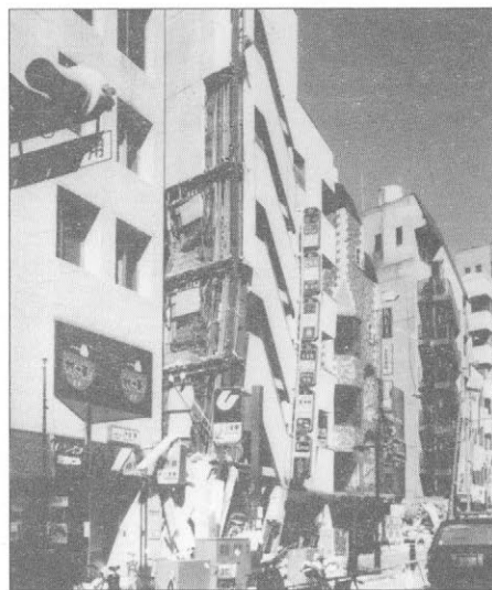
Slika 14. Nagnjena sedemnadstropna stavba jeklene konstrukcije Figure 14. Tilted seven storey building with steel structural system
