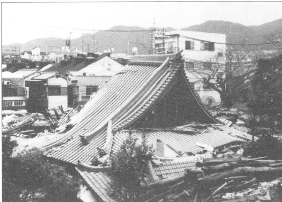
Slika 7. Porušena streha templja
