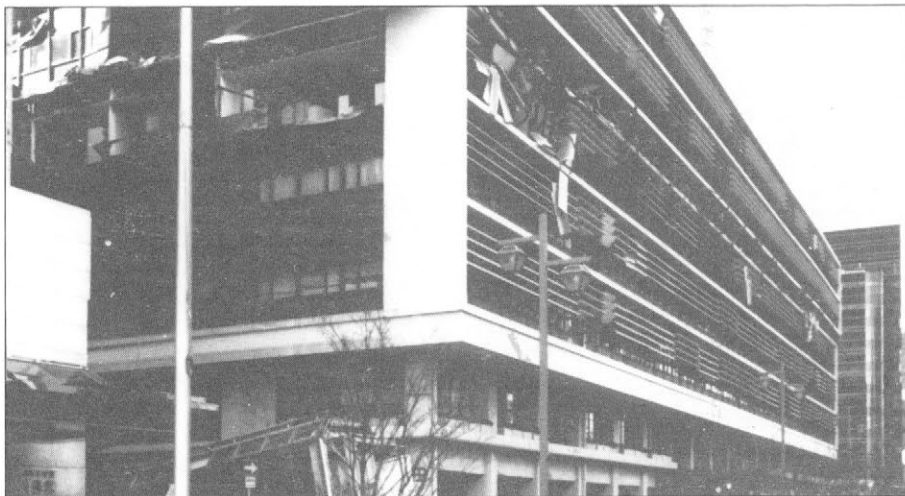
Slika 11. Porušitev šestega nadstropja armiranobetonske stavbe Figure 11. Sixth storey collapse of a r.c. building
