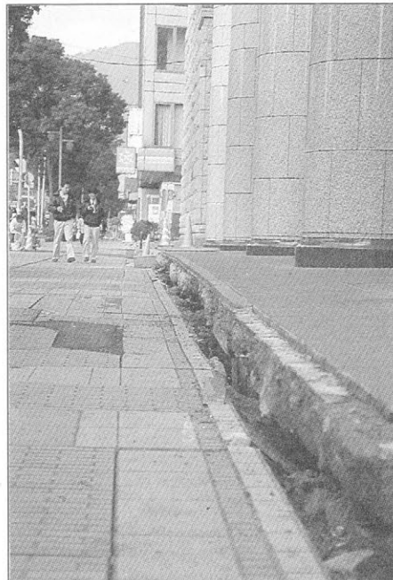
Slika 5. Posedek pločnika ob zgradbi v Sanomiji v osrednjem delu Kobeja (foto J. Lapajne)
