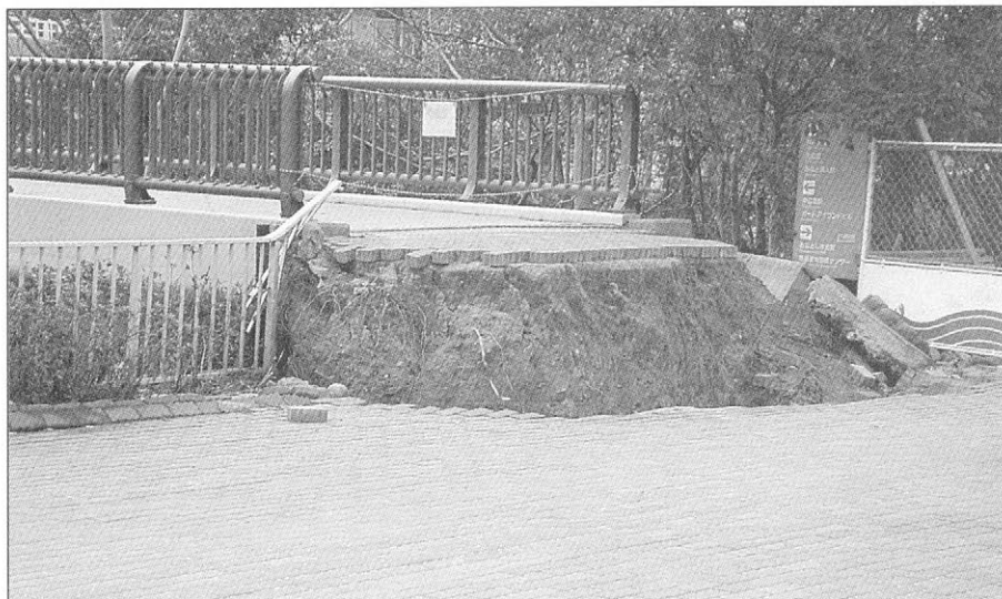
Slika 6. Posedek tal ob mostu na umetno nasutem otoku Portopia (foto J. Lapajne)
