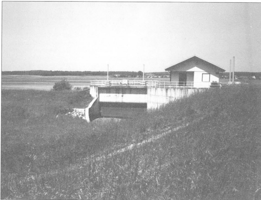
Slika 8. Suh zadrževalnik Bolehnečiči, ki skupaj z akumulacijo Gajševci varuje mesto Ljutomer pred poplavi
