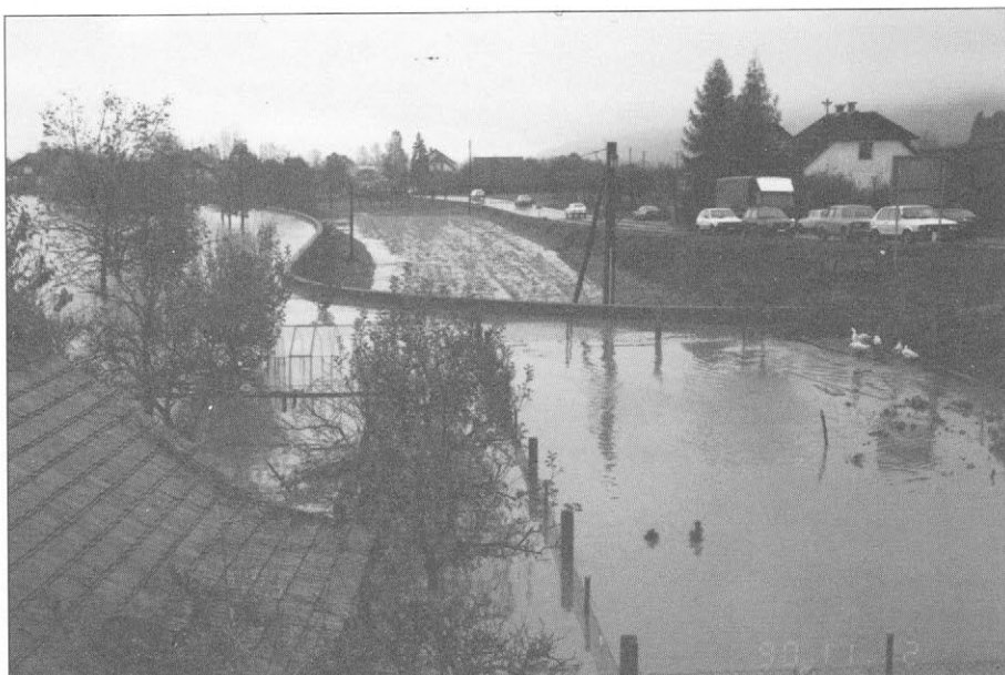
Slika 6. Obrambni zid na Savi je obvaroval del naselja Čatež in Čateške Toplice pred poplavami novembra 1990
