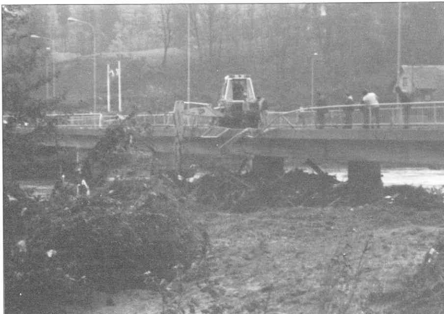
Slika 1. S plavjem zamašene mostne odprtine (most čez Savinjo pod Celjem) Figure 1. Debris laden bridge (Savinja near Celje)
