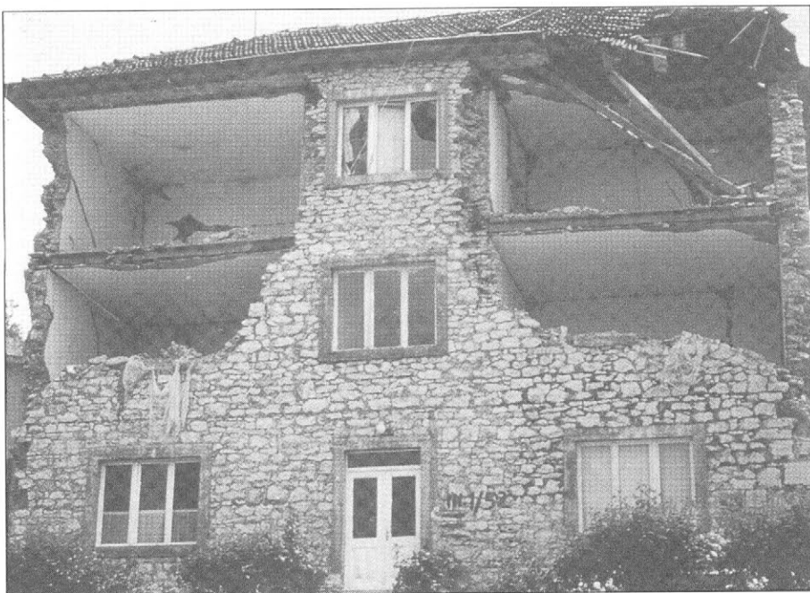
Slika 1. Potres v Črni gori, Jugoslavija leta 1979 – četrta stopnja poškodb (slikovni primer, ki ponazarja klasifikacijo poškodb, je sestavni del lestvice EMS-92) Figure 1. Earthquake in Montenegro, Yugoslavia 1979 – damage of grade 4 (examples illustrating classifications of vulnerability and damage used in the scale EMS-92)
