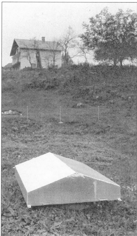
Slika 5. Pogled na jašek v ograjenem prostoru, pokrit z aluminijasto streho v potresni opazovalnici v Bojancih
