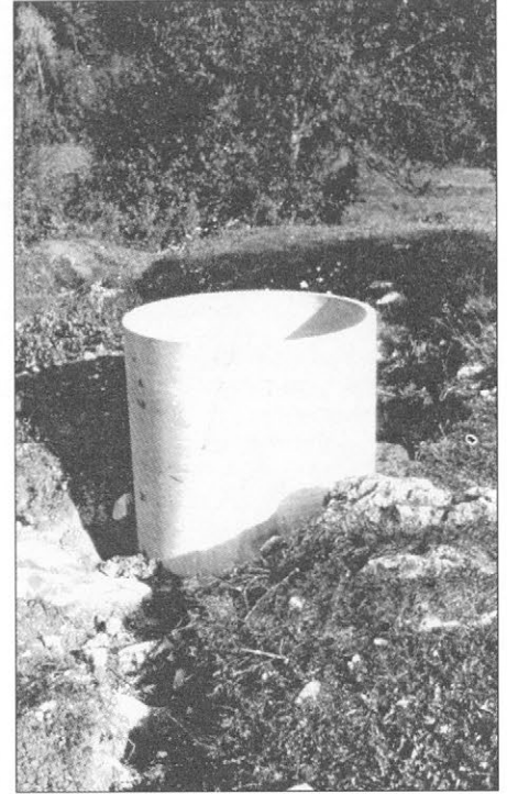
Slika 4. Postavitev avtoklavirane salonitne cevi s premerom meter in pol in debelino stene 6 cm na vodonepropustno betonsko podlago (potresna opazovalnica v Bojancih)
