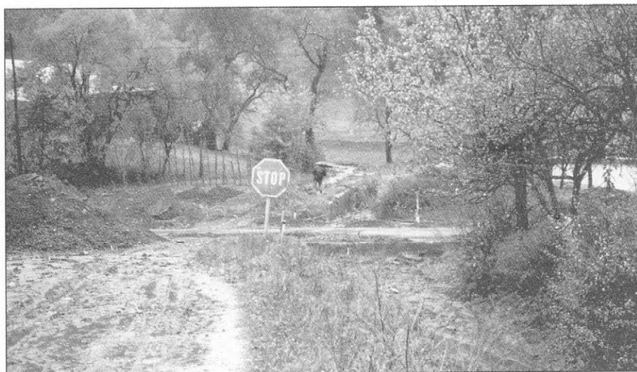
Slika 6. Tudi dovolj dimenzioniran prepust ob nepravilni trasi in niveletu ceste ne more preprečiti hudournega divjanja - magistralna cesta Ljubljana - Celje pri Blagovici (foto M. Černe)
