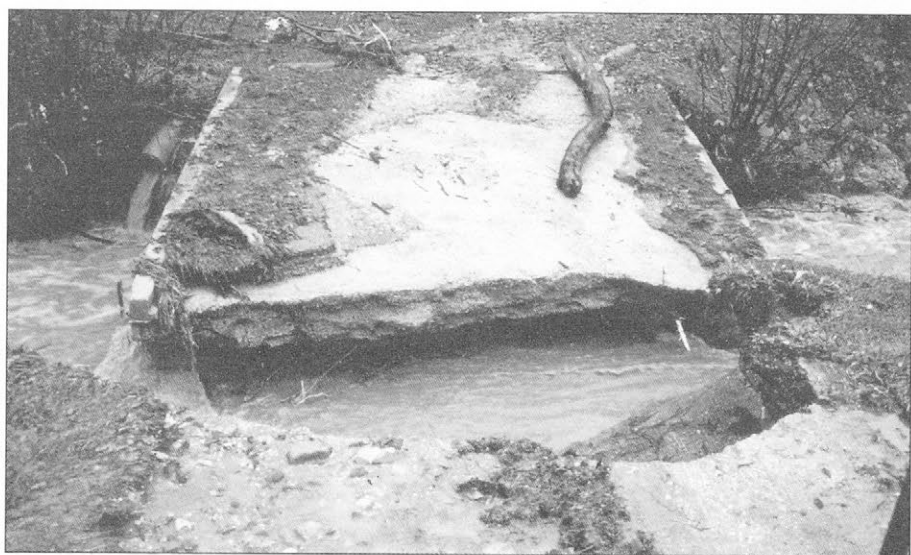
Slika 3. Hudourne vode Radomlje so leta 1992 določile pravilne dimenzije prepusta (foto M. Černe)
