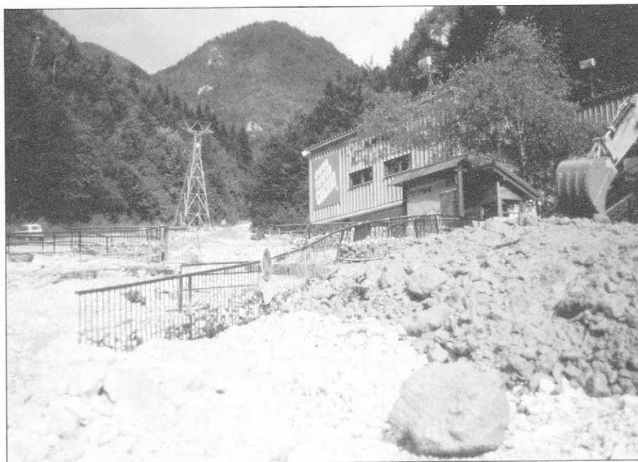
Slika 1. Hudournik Reka pod Krvavcem je 1991. leta s plavinami zasul spodnjo postajo žičnice na Krvavcu, ker že leta 1973 načrtovana ureditev hudournika ni bila v celoti opravljena (foto A. Horvat)
