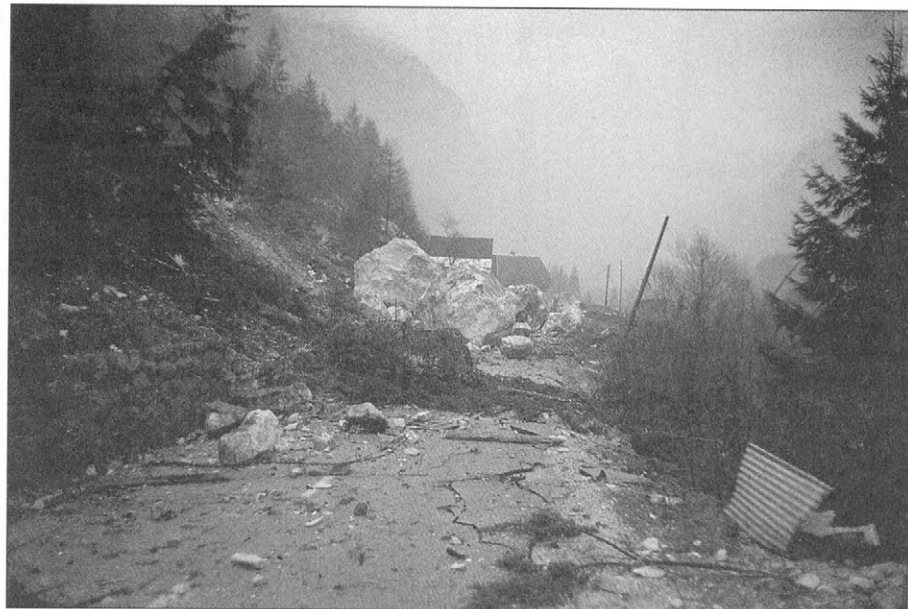
Slika 6. Poškodovana regionalna cesta Bovec–Vršič, v ozadju Fačerjeva hiša; nekaj večjih skalnih blokov se je ustavilo na cesti, asfaltna prevleka pa ni zdržala tako velikega pritiska; ostanki skal, prsti, drevja in krmilnice le še dodatno pričajo o rušilni moči skalne gmote.
