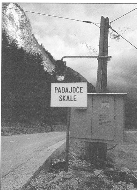
Slika 12. Signalizacijske naprave pred ogroženim cestnim odsekom so povezane s senzorji, ki so nameščeni v žarišču podora in pod njim. ob vsakem premiku skalne gmote se na semaforju prižge rdeča luč.
