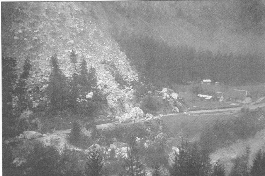
Slika 4. Pogled na spodnji del podora z najbolj poškodovanim cestnim odsekom in zasutim gozdnim pasom nad Fačerjevo hišo. Podorni kamninski bloki so se zaustavili le nekaj metrov stran od ovčje staje.
