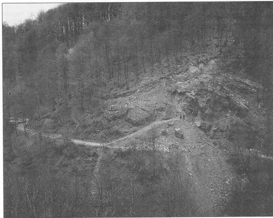
Slika 2. Zemeljski plaz na cesti Vrsno-Krn; pogled na plaz in ožje okoliško območje. Figure 2. Landslide on the Vrsno-Krn road – an overview of the endangered area.
