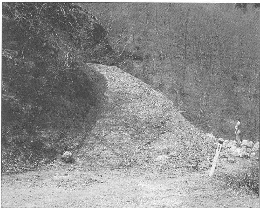
Slika 6. Sanacija zasute ceste je potekala z leve strani plazu, zatem, ko so z miniranjem odstranili še desni, nesplazeli del (v ozadju).
