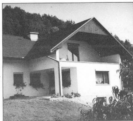
Slika 4. Pogled na novo zgrajeno hišo v Dolnjem Brezovu, kjer so nastale lažje poškodbe. (Foto: R. Vidrih).
