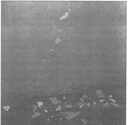
Slika 8. Odpadli koščki ometa v cerkvi v Gribljah. (Foto: M. Godec).
