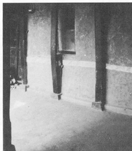
Slika 4. Detalj notranjosti bogatejše hiše z lesenimi okvirji, ki nosijo streho.
