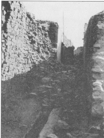
Slika 5. Porušeni zunanji sloj kamnitega zidu je zasul ulico.
