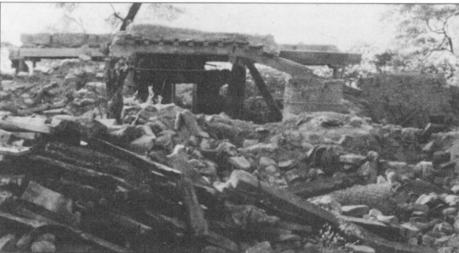
Slika 7. Leseni okviri, ki so obdržali streho tudi po porušitvi zunanjih zidov, so preprečili najhujše.
