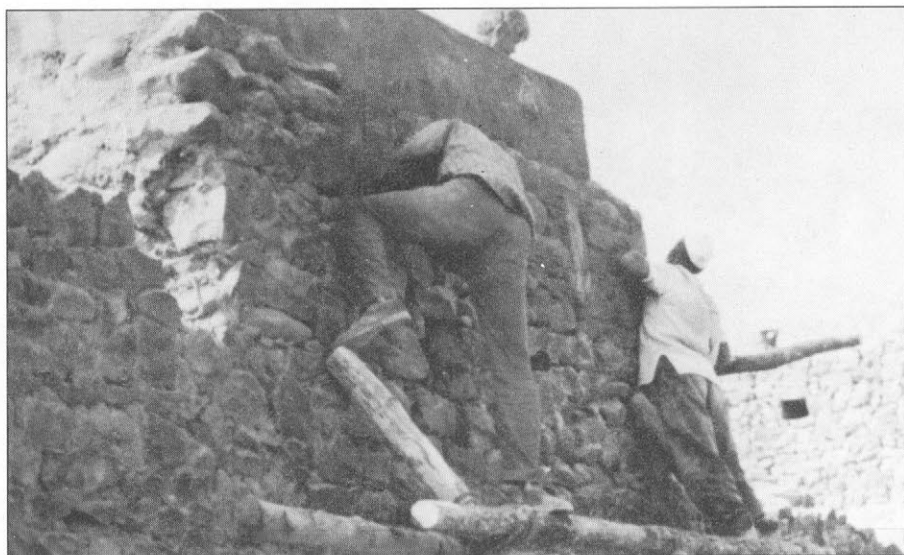
Slika 17. Povezovanje poškodovane hiše z mrežo v višini stropa.
