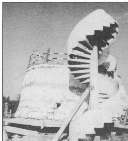
Slika 12. Vodni stolp v vasi Kawatha se je porušil zaradi torzijskih nihanj.
