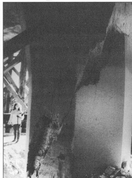
Slika 9. Stržna porušitev kratkega stebra.
