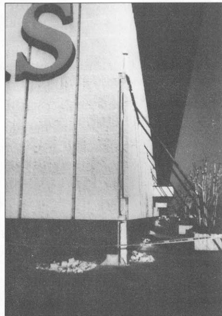
Slika 17. Porušitev povezave med težko fasado in jeklenim okvirom.
