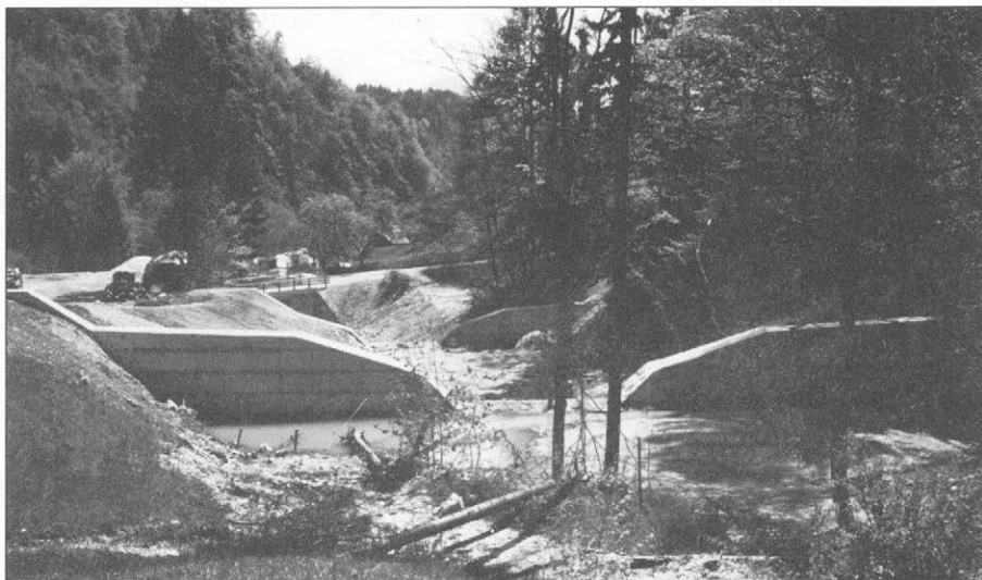
Slika 4. Bistričica v Klemenčevem – sistem zaplavno-ustalitvenih objektov in nov most na mestu odnešenega. Brežine je potrebno še ozeleniti.
