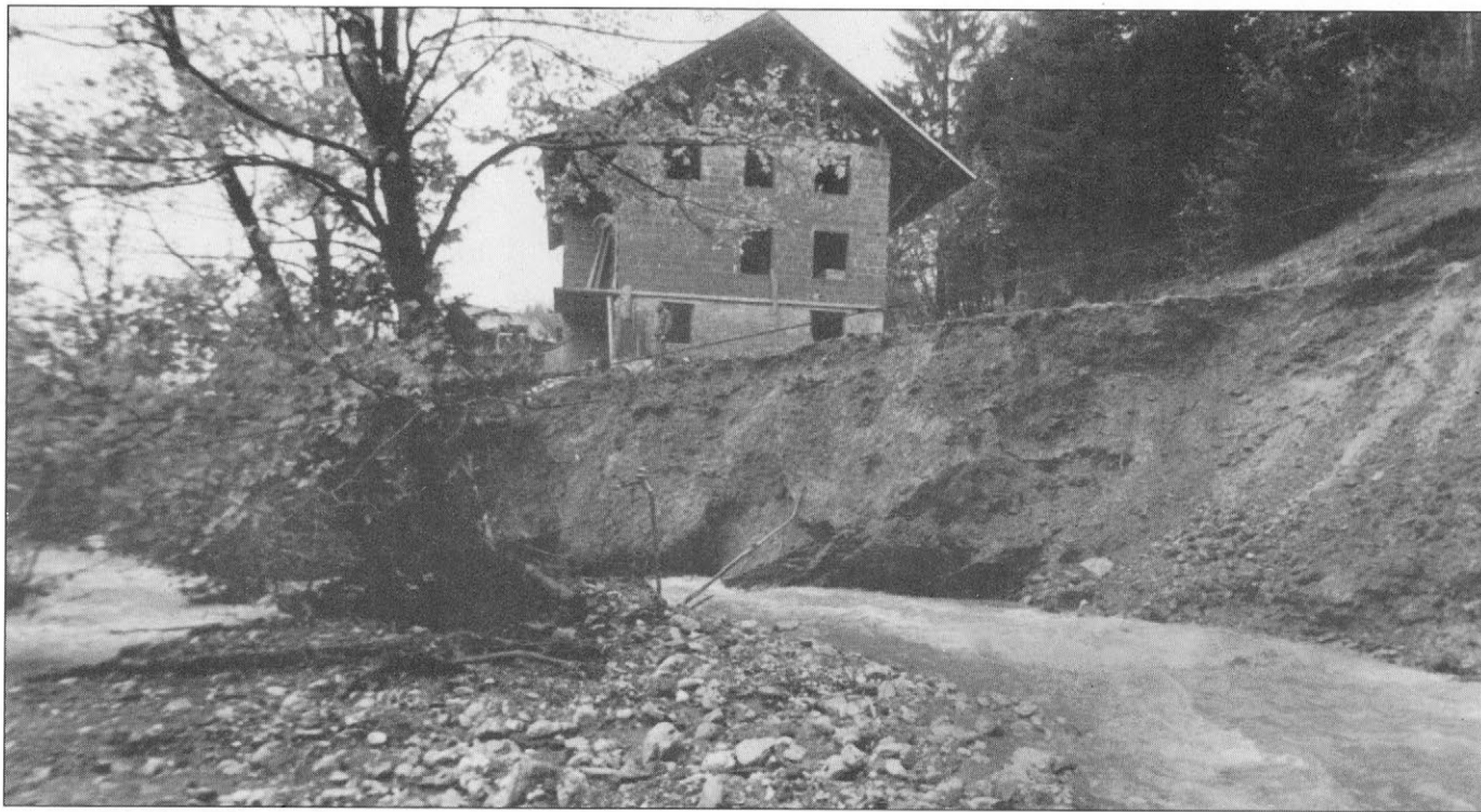
Slika 4. Karlovščica – Logarščica nad Sušo. Ovirajoče drevo na brežini je zasukalo matico hudournih vod v breg in povzročilo prestavitev struge za 12 m. (Foto: D. Durjava).
