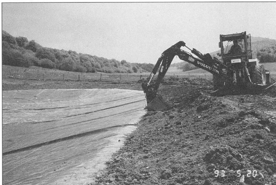
Slika 4. Sidranje robov plastične folije.
