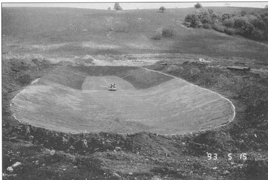
Slika 3. Valjanje dna akumulacije št. 1 pred polaganjem plastične folije.
