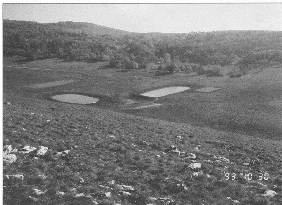
Slika 8. Pogled na vodni akumulaciji in plastično vodozbirno površino.
