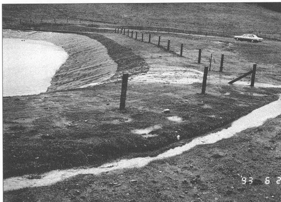
Slika 7. Odtok meteorne vode v akumulacijo št. 1.
