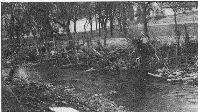
Slika 5. Desni breg Radomlje med Mlinarjem (Zg. Loke) in pritokom Friškovcem je učinkovito zavarovan s preprostimi lesenimi piloti ter z založenim vejem in šibovjem.
