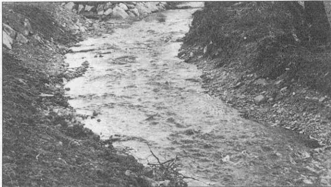
Slika 3. Po povodnji obnovljena struga Radomlje pri Mlinarju v Zgornjih Lokah, kjer dobiva z desne hudourniški Ostriženčev potok.
