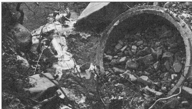
Slika 6. Javoršica, desni pritok Radomlje v Spodnjem Petelinjeku, je zasula kanal – prepust pod cesto, ki povezuje naselji Javorje in Suša.
