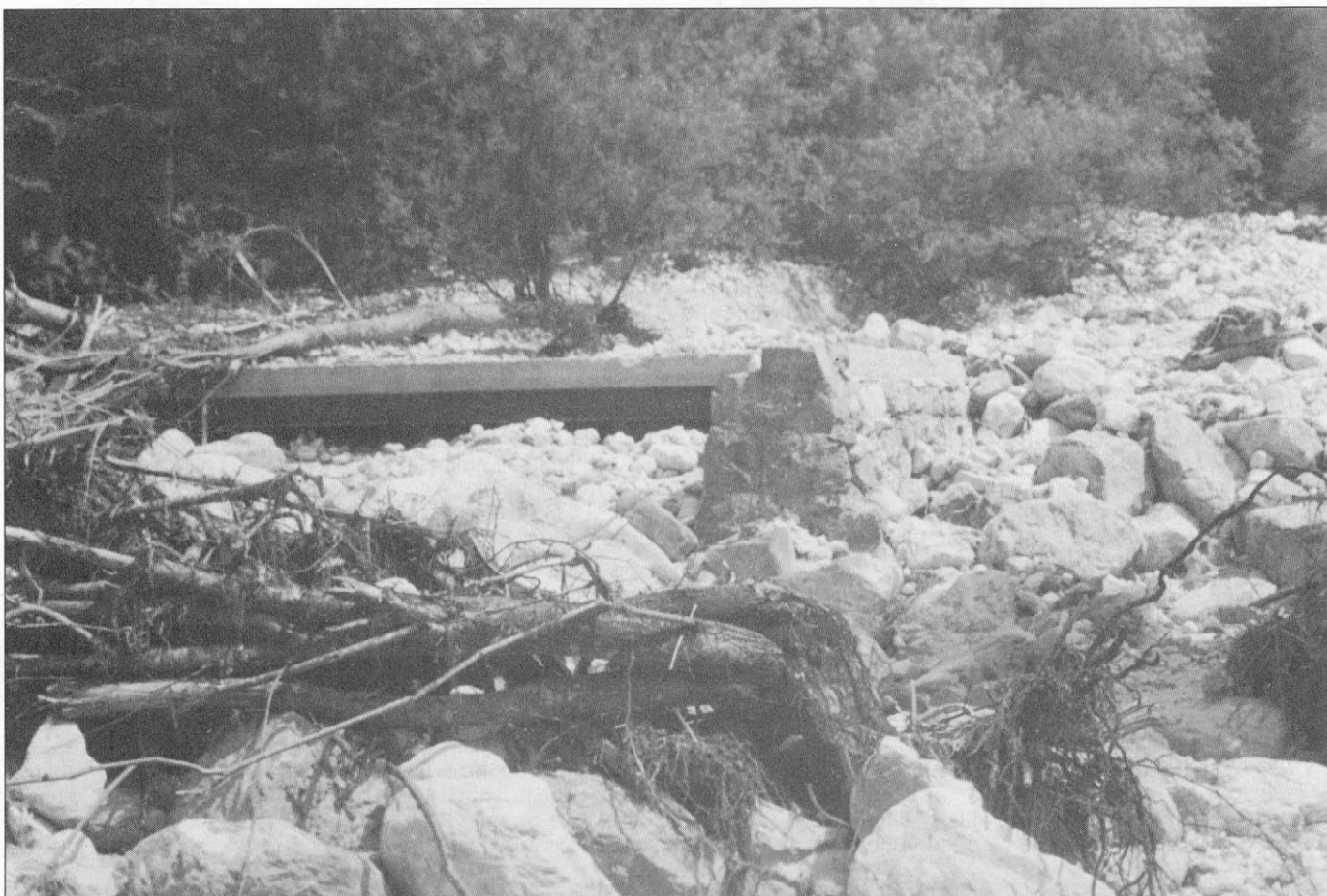
Slika 2. Most s premajhno svetlo odprtino je bil ob izbruhu hudournika mimogrede zamašen z navlako in grobimi plavinami. Stihija razdivjanih vod je zato udarila ne le čezenj, temveč tudi mimo njega in razdejala tudi lokalno cesto. – Foto: V. Paulič.
