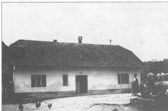
Slika 5. Pregled na stanovanjsko hišo v Vrbovcu. Hiša je bila vzdrževana, omet in streha obnovljena. (Foto: R. Vidrih).
