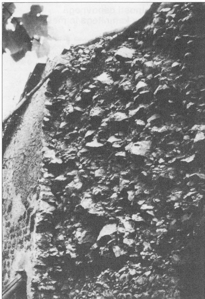
Slika 1. Tako se med potresom razsloji kamniti zid, sezidan iz dveh slojev neobdelanega kamna. (Foto: M. Tomaževič).
