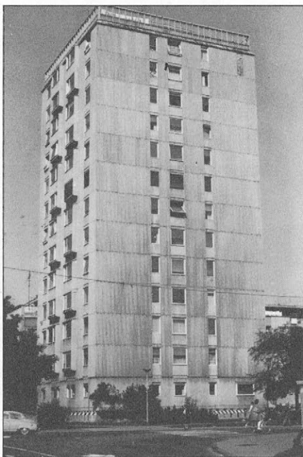
Slika 5. Med potresno najbolj ogroženimi objekti v Ljubljani so visoke zidane stolpnice, sezidane v petdesetih letih. (Foto: P. Sheppard).
